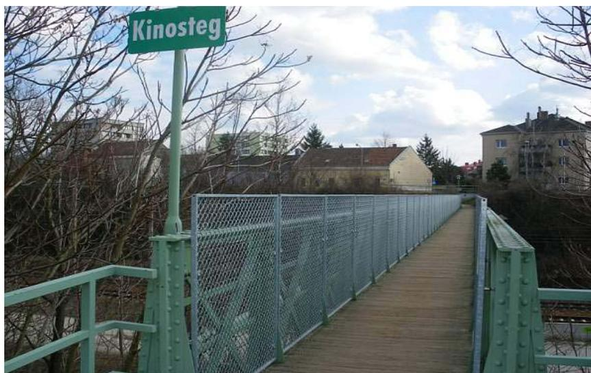
*Stahlgitter statt Glasplatten an den beiden Stegen*
