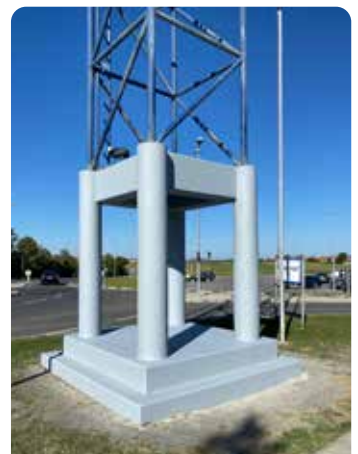
.. und Schutzanstrich versehen
