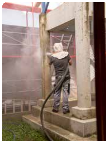
... mit Sandstrahl gereinigt
